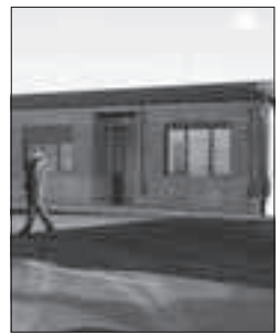
Il centro di Mortara che una volta completato sarà gestito dalla Comarc
