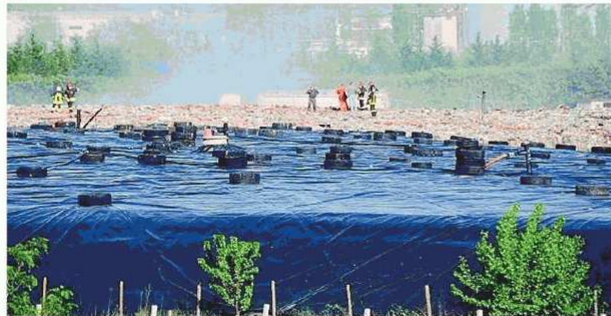
La discarica di Pecol dei Lupi chiusa dal 15 gennaio ma al centro di un contenzioso
