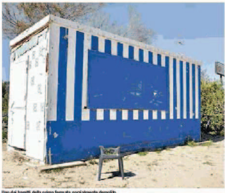
Uno dei baretto della prima fermata parzialmente demolito
