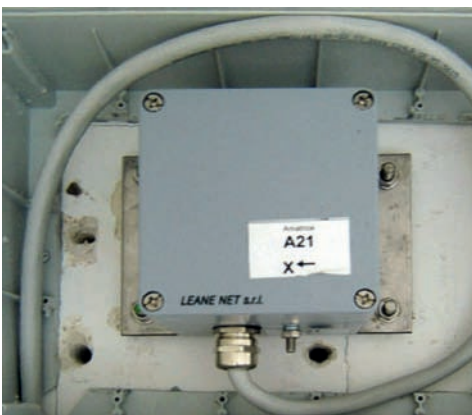
Figura 2 Le componenti principali di un sistema di monitoraggio sismico: (da sinistra a destra) la terna accelerometrica al suolo, un accelerometro fissato sulla struttura, unità per l'acquisizione e la registrazione dei dati.
