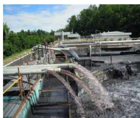
**Bypass idrico per il depuratore**
